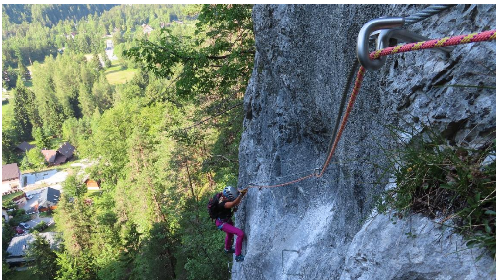
Moderne ferate imajo na nosilnih klinih nameščene še zavihke za pomoč pri varovanju z vrvjo
