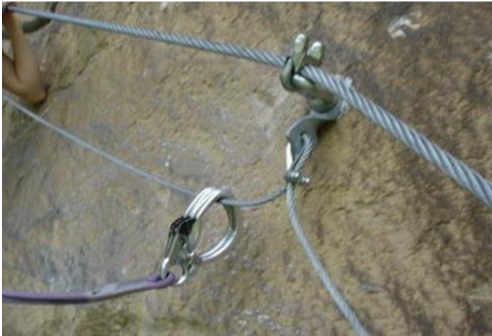
Debelejša, napeta jeklenica je namenjena oprijemanju, tanjša, ohlapna jeklenica pa samovarovanju
